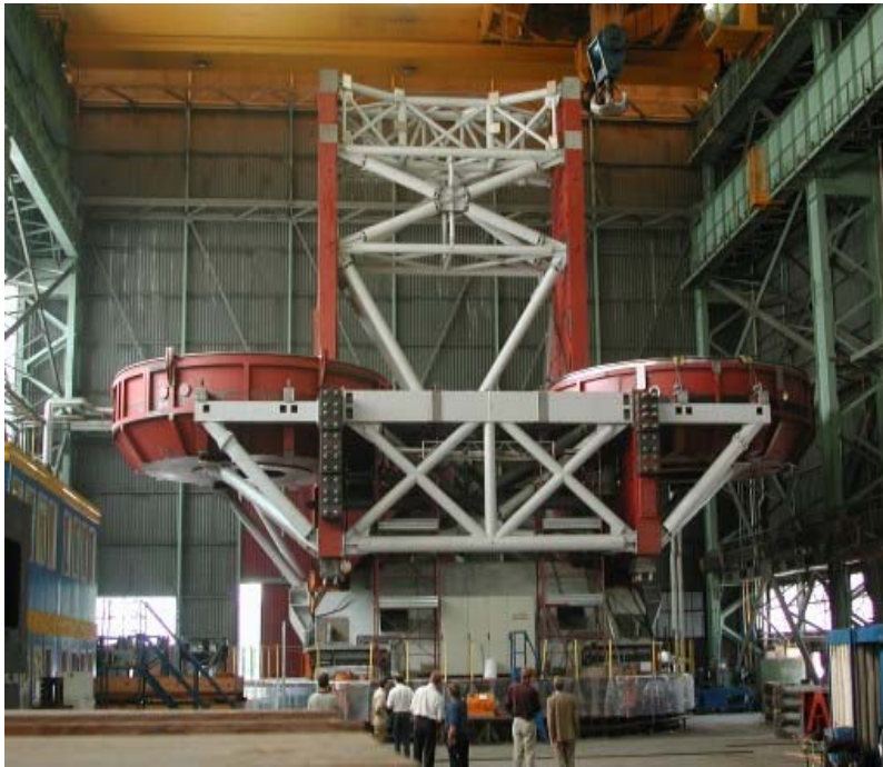
Abbildung 1.4.13: Das LBT während der Bauphase.
