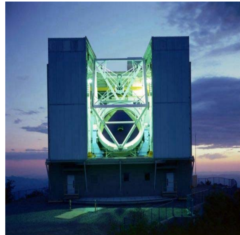
Abbildung 1.4.8: Das heutige "Monolithic Mirror Telescope" (ebenfalls MMT) mit einem einzelnen 6.5m - Spiegel und einem 2 1/2 -fach höheren Lichtsammelvermögen.
